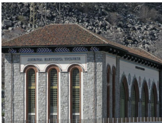
Una centrale elettrica rigenerativa AET in Ticino. Foto: : Amanda Slater, Wikimedia, CC BY-SA 2.0
